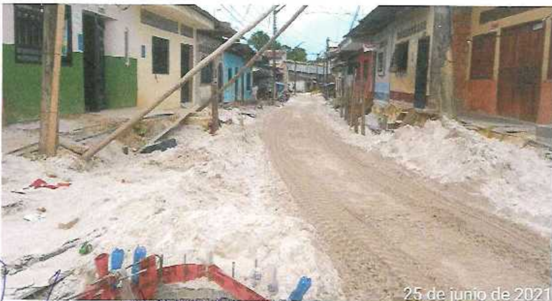
FOTOGRAFÍA 16: RELLENO A NIVEL DE SUB RASANTE EN LA CALLE 04 DE SETIEMBRE
