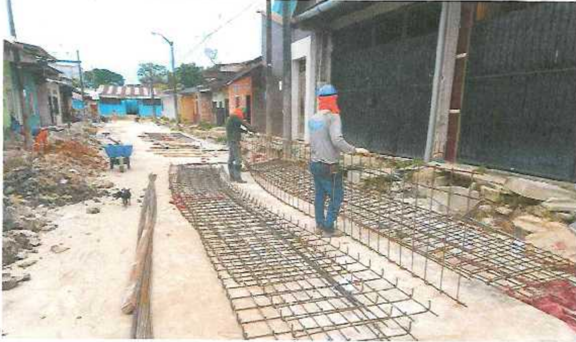
FOTOGRAFÍA 13: HABILITACION DE ESTRUCTURA DE ALCANTARILLA
