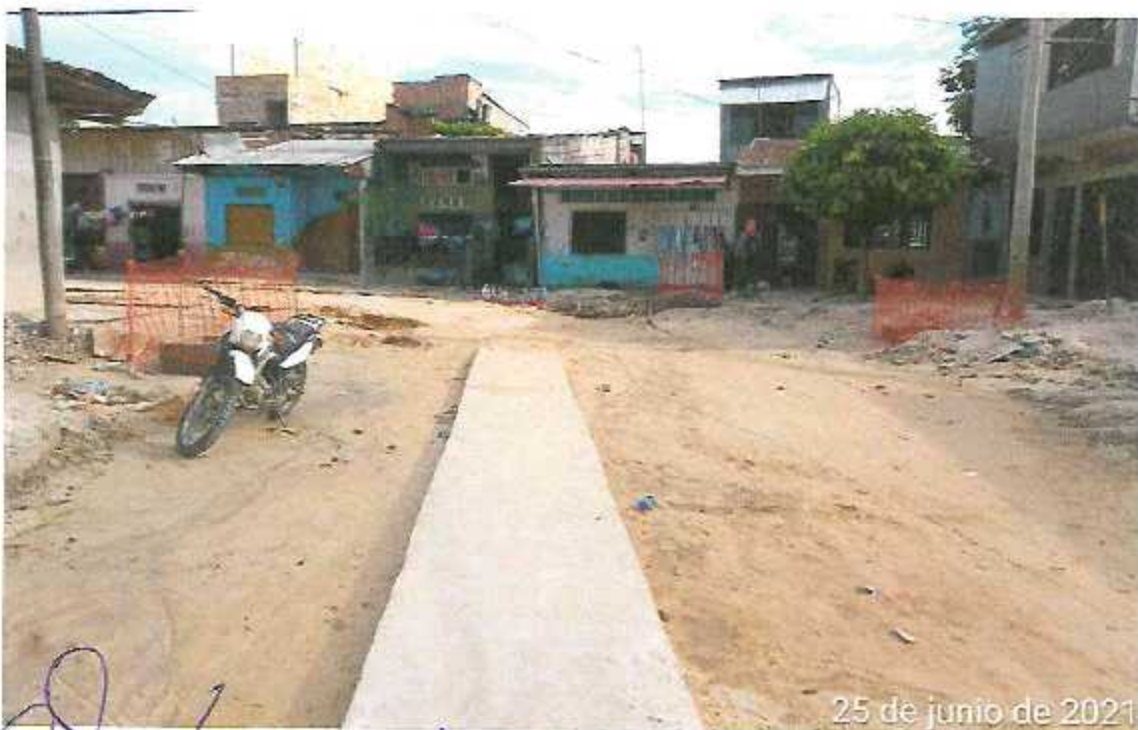
FOTOGRAFÍA 14: RELLENO EN EL PASAJE SECOYA A NIVEL DE SOBREECAVACION
